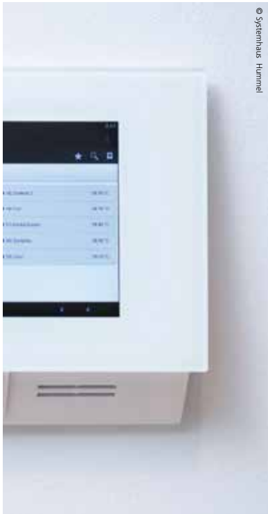
Ein Blick auf die Heizungssteuerung: Jeder Raum kann separat eingestellt werden. Der Smart-Home-Server gibt die entsprechenden Anweisungen an die einzelnen Heizgeräte weiter.
