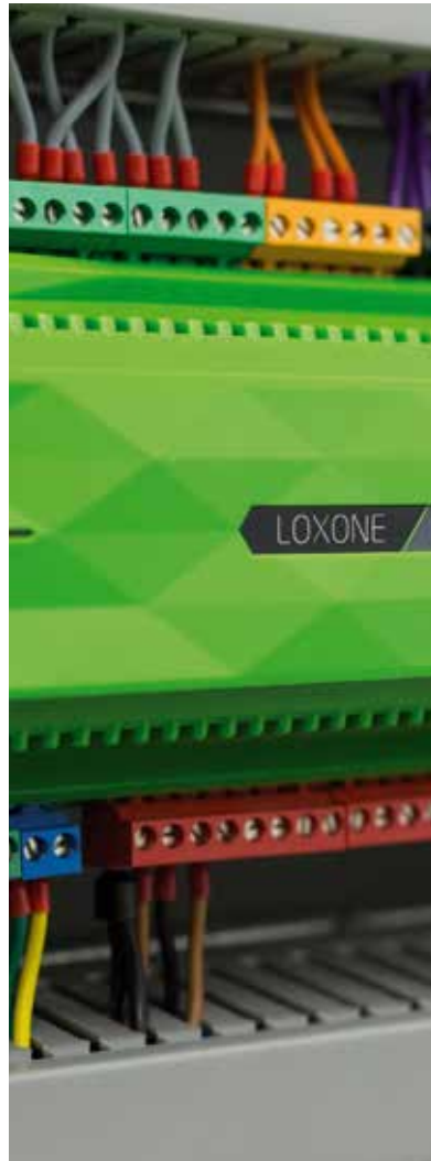
Der Smart-Home-Server: Hier laufen alle Nervenstränge des Gebäudes zusammen und hier werden die Entscheidungen getroffen.
